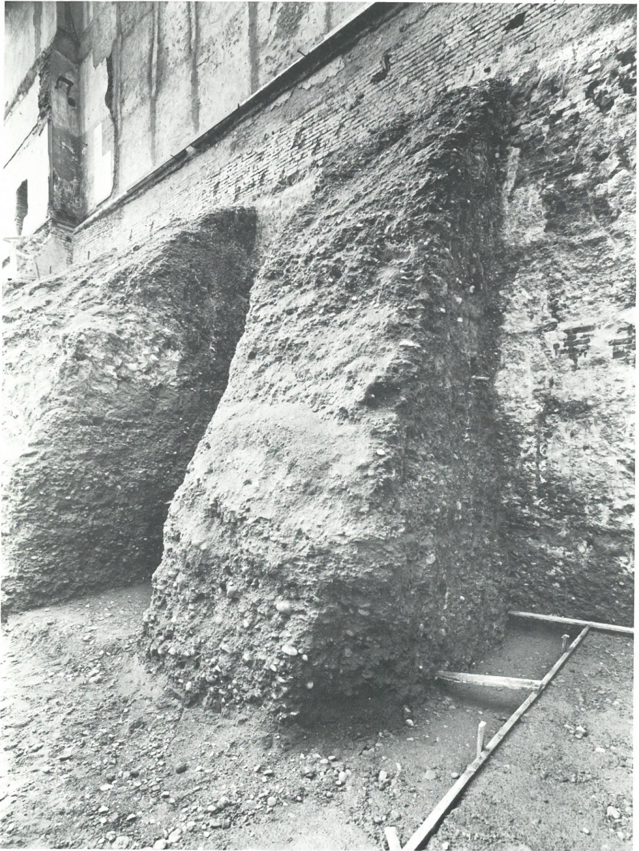
Foto 9 - Ricostruzione HOTEL DU NORD (Piazza Repubblica) Particolari degli scavi in adiacenza dell'edificio vicino, eseguiti per tratti di lunghezza di 3,00 m. circa. Si può notare la compattezza del terreno consolidato costituente gli speroni di sostegno.
