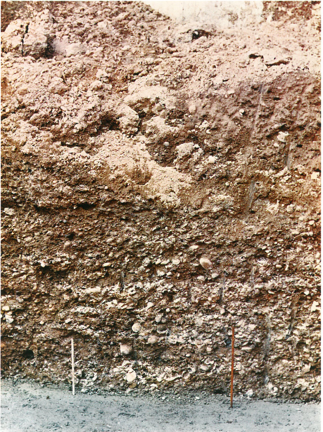
Foto 5 - Via CESANA Particolare della parete verticale dello scavo in terreno consolidato sotto le fondazioni della casa adiacente.
