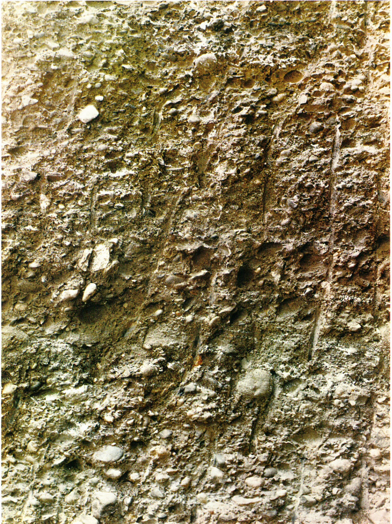
Foto 2 - Particolare di terreno alluvionale trattato con iniezioni di cemento e chimiche. Si può osservare l'uniformità di diffusione delle miscele consolidanti ed anche l'alto grado di consolidamento ottenuto. Come si vede qualche grosso ciottolo è stato tranciato durante lo scavo con martello demolitore. (La foto è stata scattata al cantiere HOTEL DU NORD).
