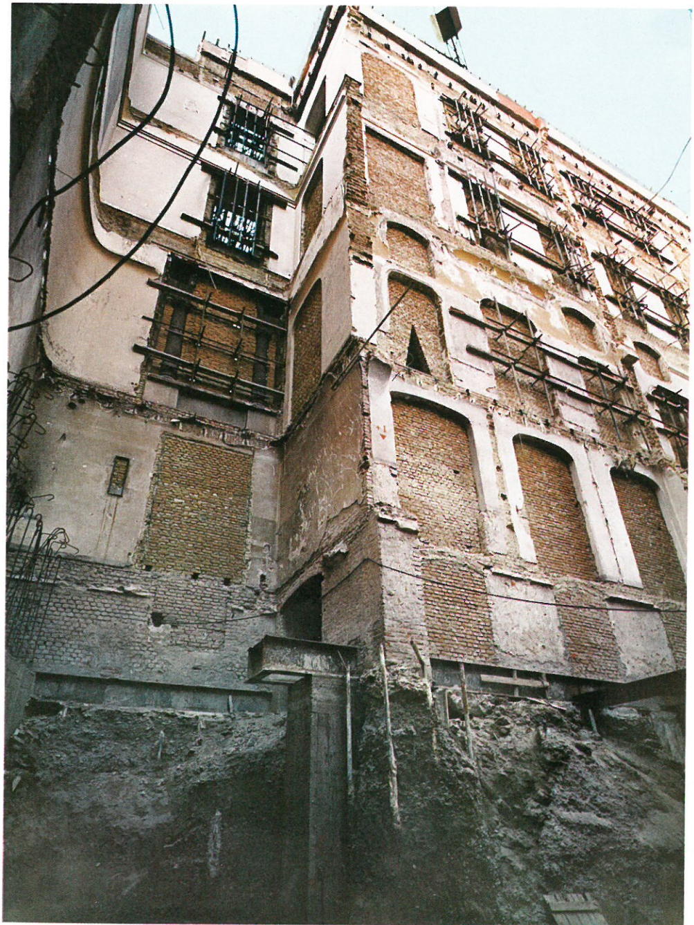
Foto 15 - Corso Venezia - PALAZZO CASTIGLIONI La stessa muratura della foto precedente vista dal fondo degli scavi all'interno dell'edificio. In basso il terreno trattato ed un pilastro della nuova struttura.
