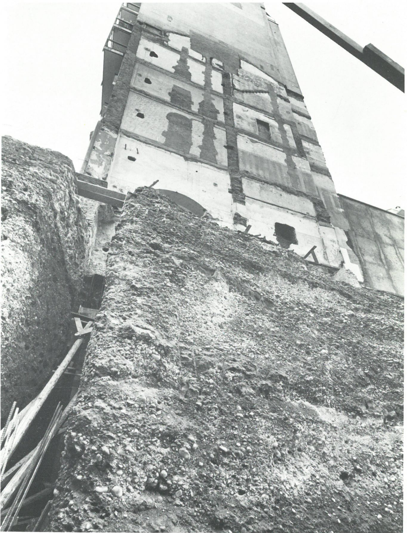
Foto 8 - Ricostruzione HOTEL DU NORD (Piazza Repubblica) Scavi in adiacenza di una costruzione alta 40.00 m. Impostazione di un pilastro del nuovo edificio attraverso una trincea scavata in terreno trattato con iniezioni. I puntoni in legname sostengono la casseratura del pilastro del quale si intravedono i ferri nella parte alta.
