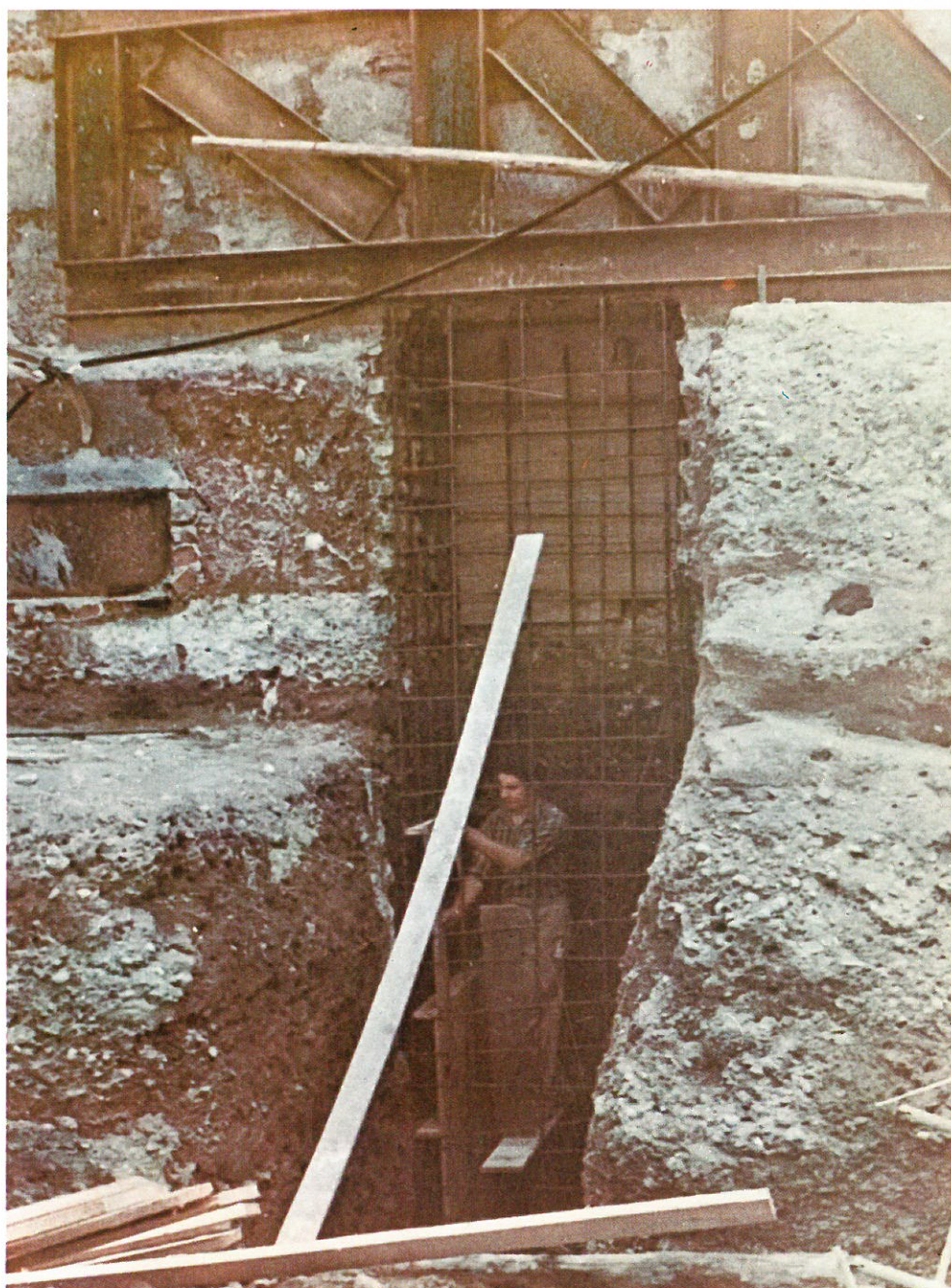
Foto 17 - Corso Venezia - PALAZZO CASTIGLIONI L'armatura del plinto e del pilastro è ormai completata. Un operaio sta mettendo in opera la casseratura in legname per il contenimento del getto. Si può notare come il terreno consolidato svolga perfettamente la sua funzione di sostegno durante gli scavi di sotto-murazione.
