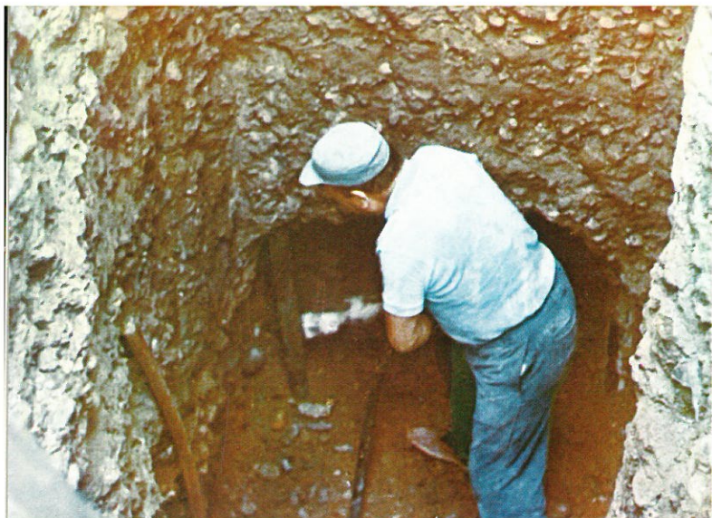
Foto 16 - Corso Venezia - PALAZZO CASTIGLIONI Un operaio, dopo avere ultimato lo scavo in trincea attraverso il terreno consolidato, sta eseguendo una nicchia sotto le vecchie fondazioni per la impostazione del plinto di un pilastro della nostra struttura.
